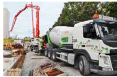
De två betonghybridbilarna är utrustade med eldrivna roterare, vilka körs på fossilfri diesel HVO100. Roteraren laddas via en generator under körning och kan sedan drivas i fyra timmar på en laddning. Förutom minskade utsläpp bidrar det till en bättre arbetsmiljö med mindre avgaser och buller.
