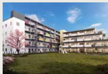
I Jessheim/Gardermoen bygger Peab Yesheim III, vilket omfattar 103 lägenheter med byggstart i september 2017. Bostäderna beräknas stå klara för inflyttning kvartal 2, 2019.
